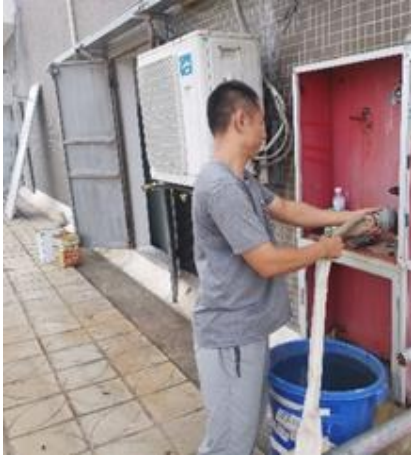
连接消火栓准备进行灭火
