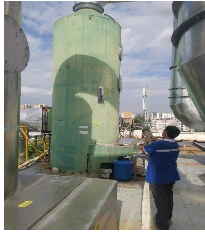
对喷淋塔进行灭火
